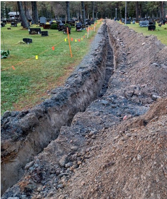
Kuva 11 SÄHKÖAUTOJEN LATAUSPISTEEN SÄHKÖKAAPELIKAIVANTO ENSIMMÄISELLÄ PÄÄKÄYTÄVÄLLÄ.
