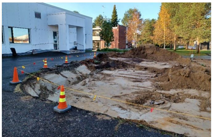
Kuva 9 Nuorisotilan etupihan pohjatyöt syksyllä.
